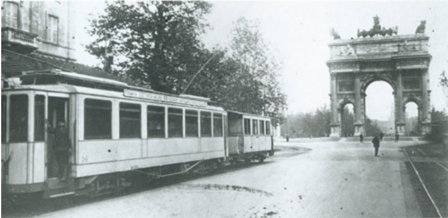
Capolinea del tram di collegamento da Milano a Gallarate ( 1915 )
